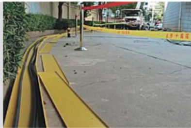
电缆保护槽盒 用于旁路电缆的敷设及保护。
