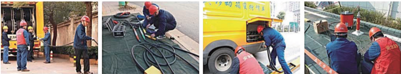
高压旁路电缆敷设
