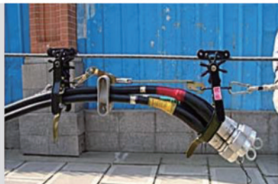
牵引头 用于旁路电缆终端保护及旁路 电缆敷设牵引。
