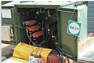
旁路作业辅助电缆 (安装可带电插拔肘型终端) 用于旁路作业系统与美式电缆 分支箱和美式箱变的电气连接。
