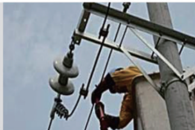
旁路作业辅助电缆 (安装绝缘引流线夹) 用于旁路作业系统与架空线路 的电气连接。
