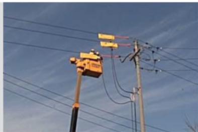
绝缘横担 安装在电杆上, 支撑旁路引下 电缆, 减少旁路引下电缆对架 空导线的负重。
