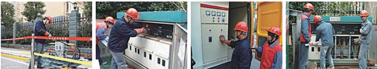
得到调配许可后，旁路线路送电及旁路开关电流检测
