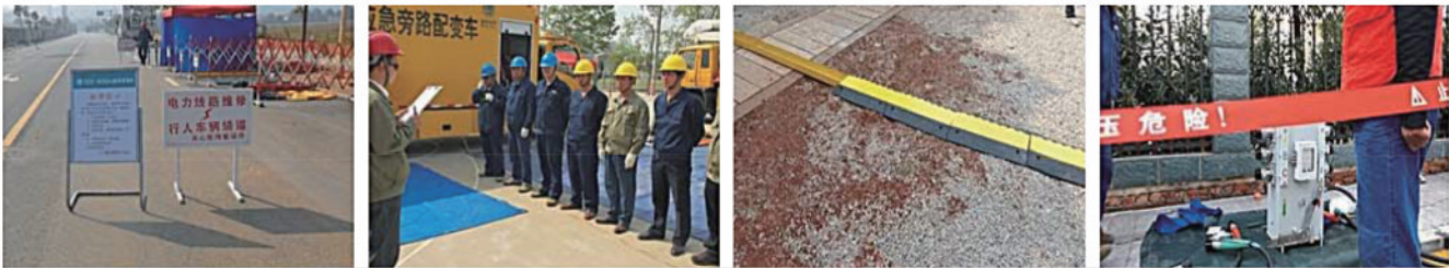
现场安全措施设置
