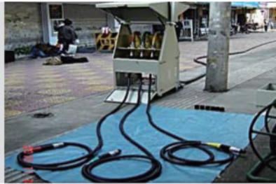
电缆转换箱 用于旁路柔性电缆与普通XLPE 电缆连接。
